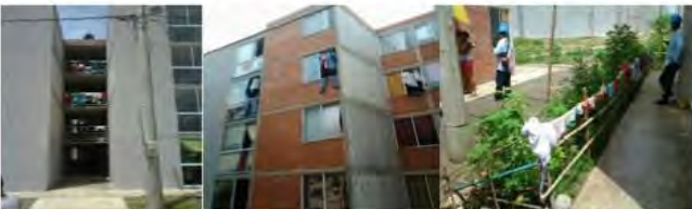
A pesar de que debe existir un acceso a patio con ventilación directa, en la urbanización no se encontró ningún espacio con dichas características.
