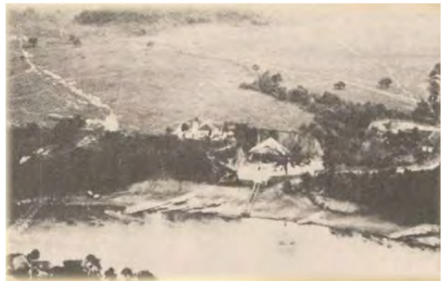
Vista aérea de la base-cuna aviación militar y rampa de SCADTA
